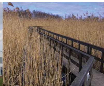
Gangbro gennem svært tilgængeligt terræn
